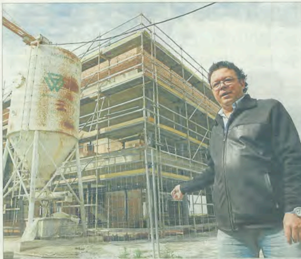
Juan Luis Jaén, presidente de Barrio Unido, junto a las obras semiparalizadas del centro de salud. / CONCHITINA
